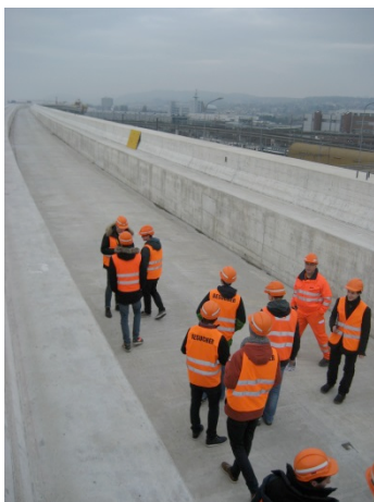
Bild 2: Gruppe auf dem fertigen Trog der Brücke
