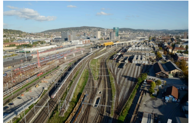
Bild 1: Baustelle Letzigrabenbrücke, 1. Abschnitt
